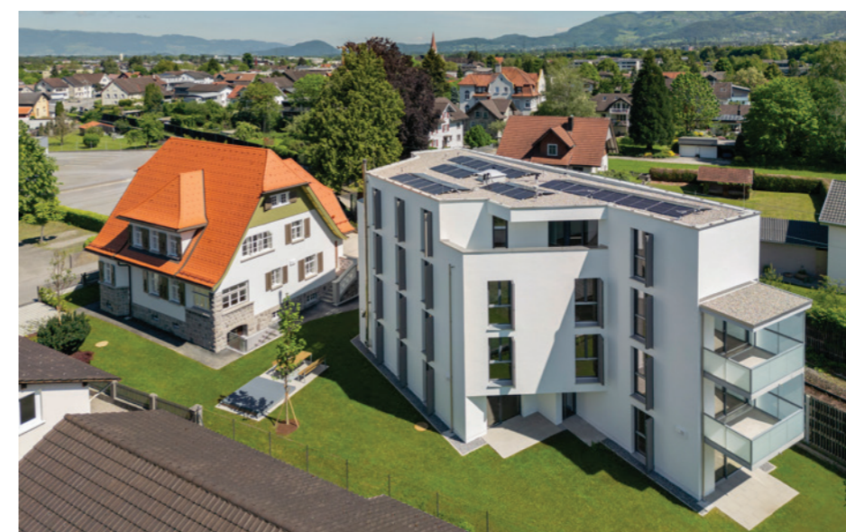
Mit dem Umbau der Villa und dem Neubau nebenan wurde im November 2022 begonnen.
