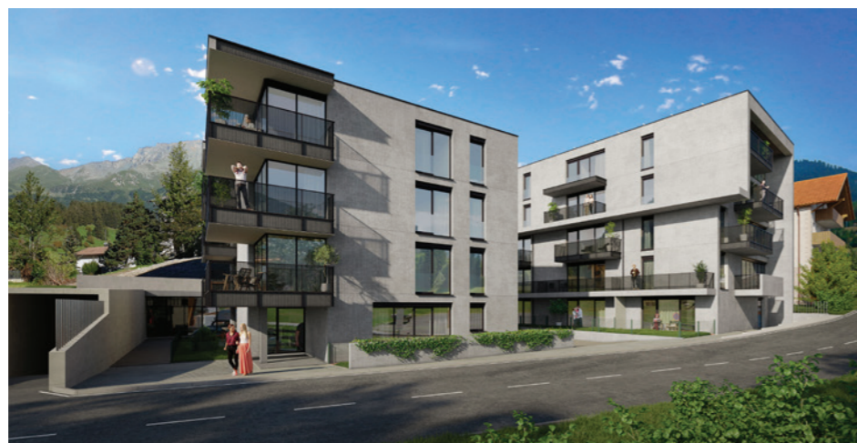
Die Fertigstellung der neuen Wohnanlage in Nauders ist für Oktober 2025 geplant.
