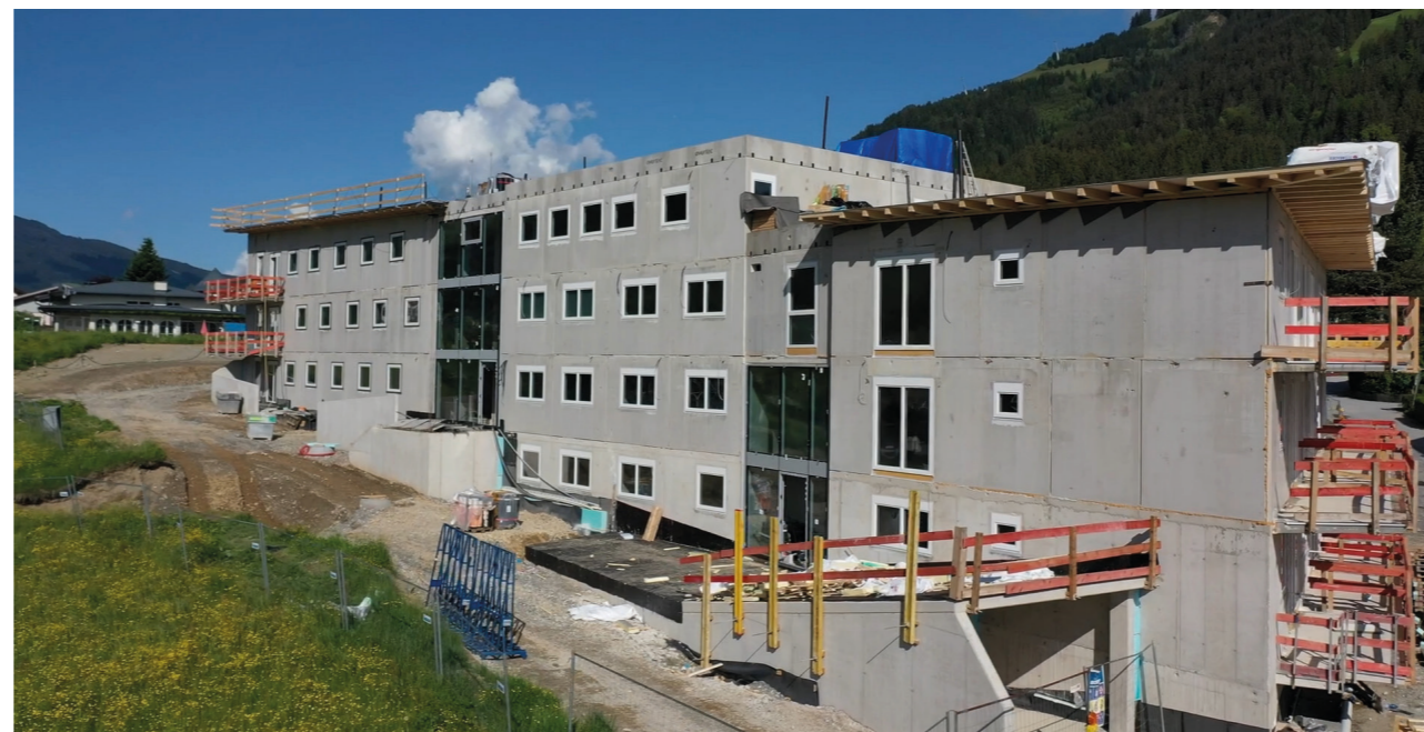
Work in Progress: Ein Blick auf die Baustelle in Westendorf. Die Arbeiten gehen gut voran (hier Stand Ende Mai 2023).
