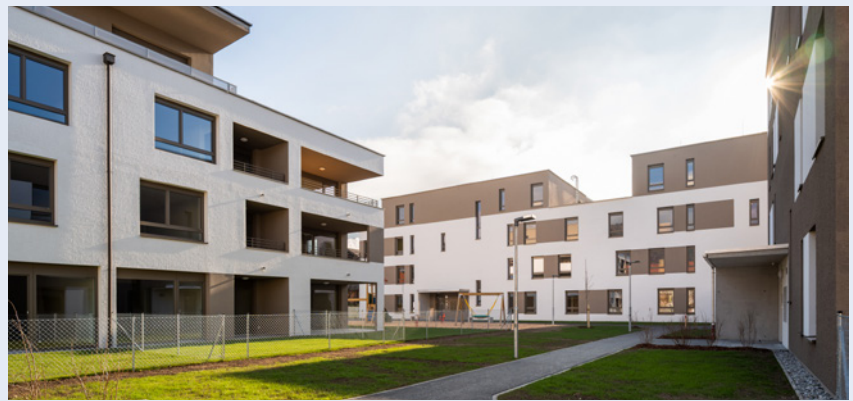
In der Peter-Rosegger-Straße in Wattens finden Miet-, Eigentums- und betreute Wohnungen in einer Wohnanlage mit drei Gebäuden Platz.
