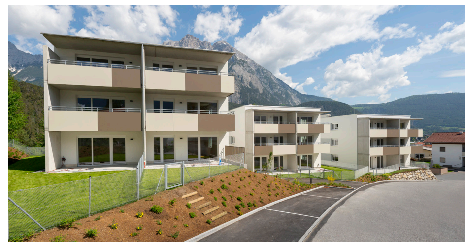
In Telfs konnten beide Bauabschnitte (Nord/Süd) erfolgreich übergeben werden.
