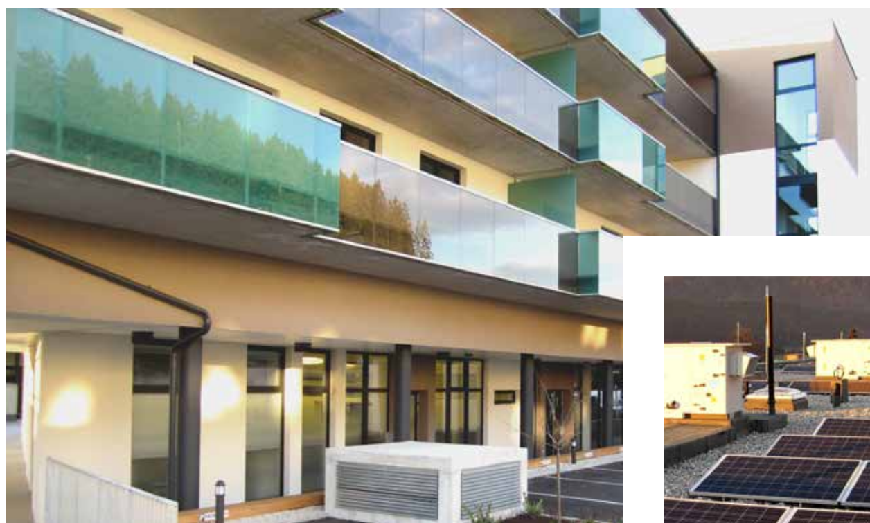
Die Anlage in Kirchbichl war die erste der Alpenländischen bei der die Kaskadenheizung eingesetzt wurde.
