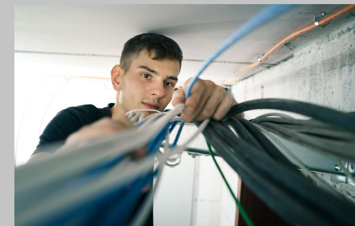
... die Brandschutz- und Sicherheitsvorkehrungen auf den modernen Stand der Technik gebracht.
