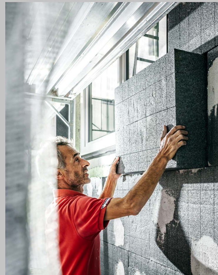
... 20 Zentimeter Hochleistungs-Dämmung auf der Fassade angebracht.
