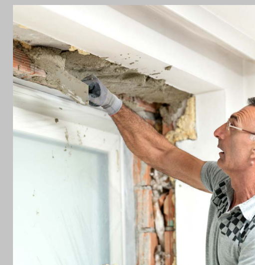
... die Wärmebrücken am gesamten Gebäude analysiert und ausgeschlossen. Unter anderem dadurch, dass alle Fenster in die Dämmebene versetzt wurden.
