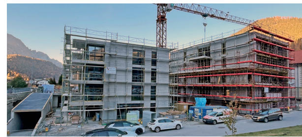
Die zwei Baukörper in Nauders im Rohbau mit kerngedämmten Betonfertigteilmwänden.
