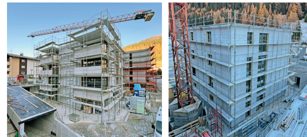
Die zwei Baukörper in Nauders im Rohbau mit kerngedämmten Betonfertigteilmwänden.
